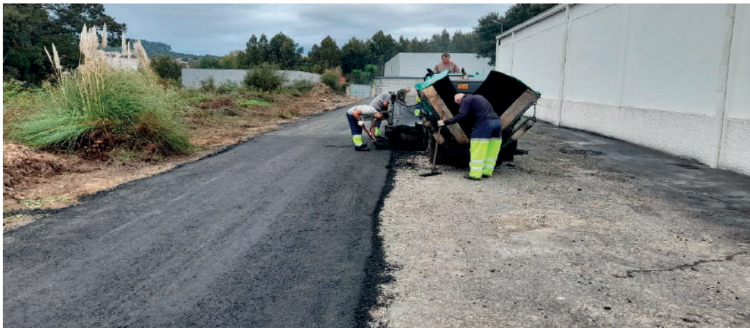
Fig. Repavimentação de arruamentos por administração direta
