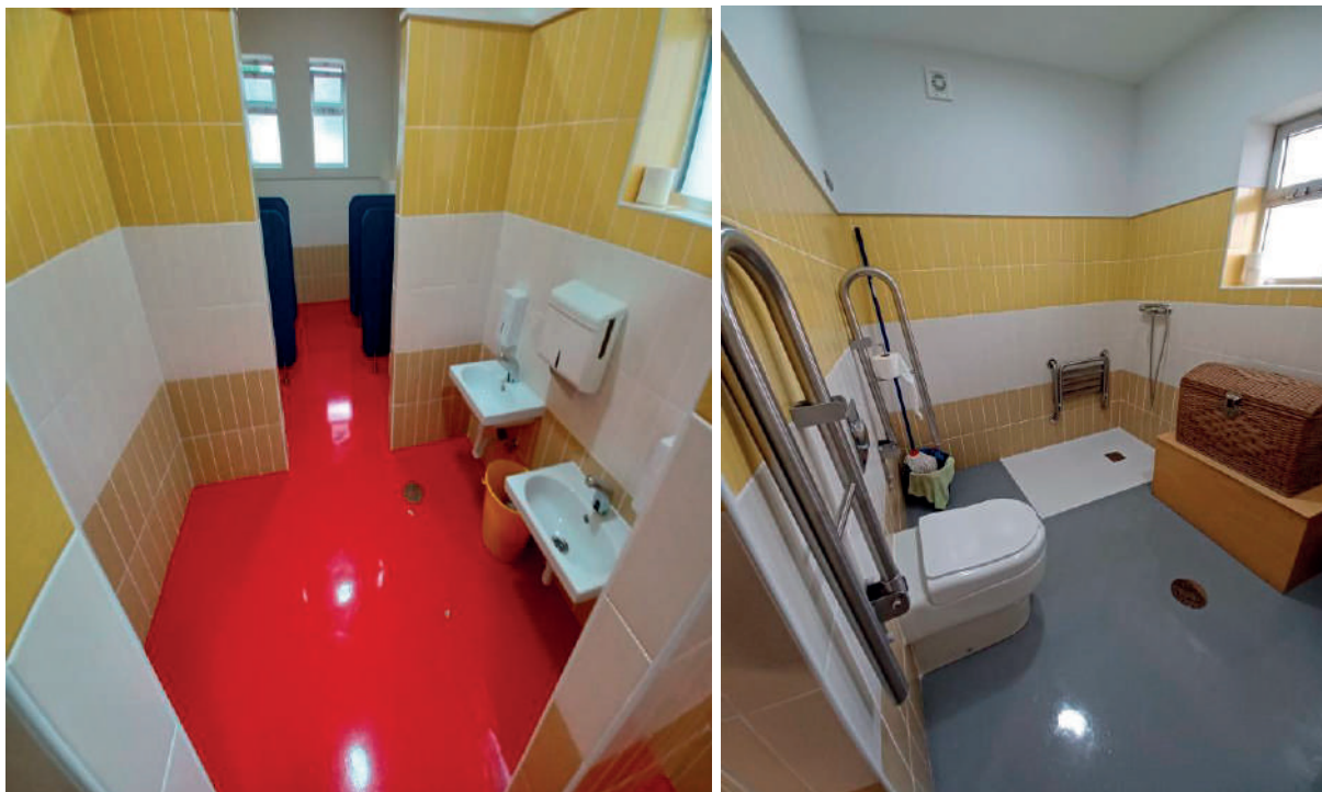
Fig. Aspeto final dos sanitários no JI de Ordonhe após conclusão dos trabalhos
