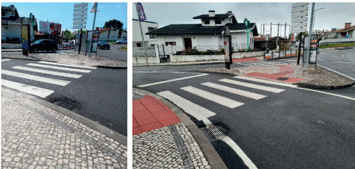
Fig. Aplicação de pavimento tátil em passagens para peões
