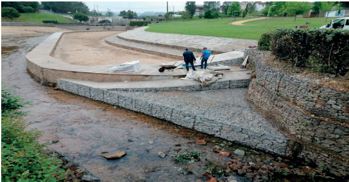
Fig. Construção das rampas de acesso à linha de água na Praia Fluvial da Mâmoa
