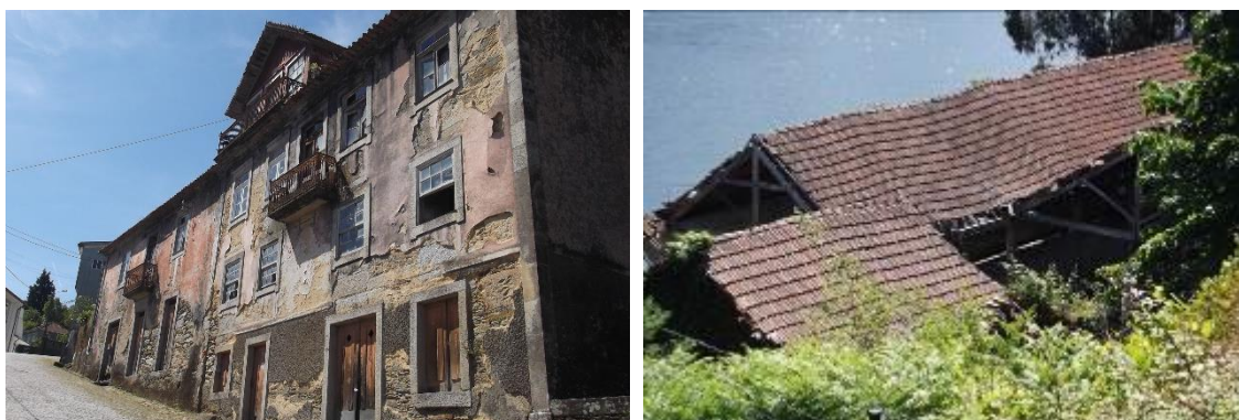
Figuras 6 e 7 | Edifício com necessidade de intervenção e pormenor da cobertura da antiga fábrica
