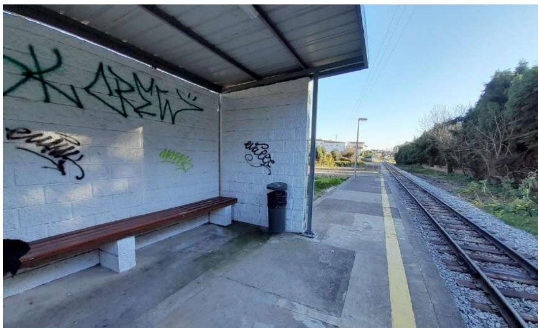
Figura 123. Equipamentos de apoio ao utilizador no cais do apeadeiro Arrifana
