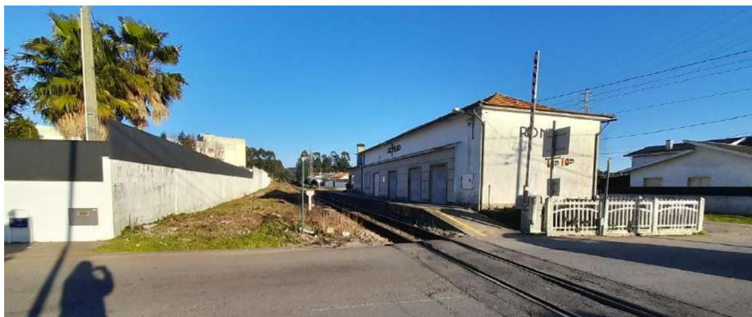
Figura 125. Acesso pedonal ao apeadeiro Rio Meão
