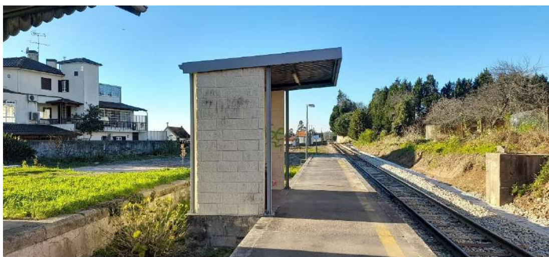
Figura 113. Equipamentos de apoio ao utilizador no cais do apeadeiro
