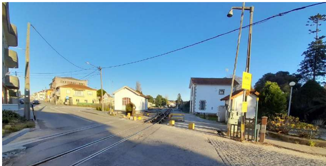
Figura 92. Ausência de passeios junto à passagem de nível
