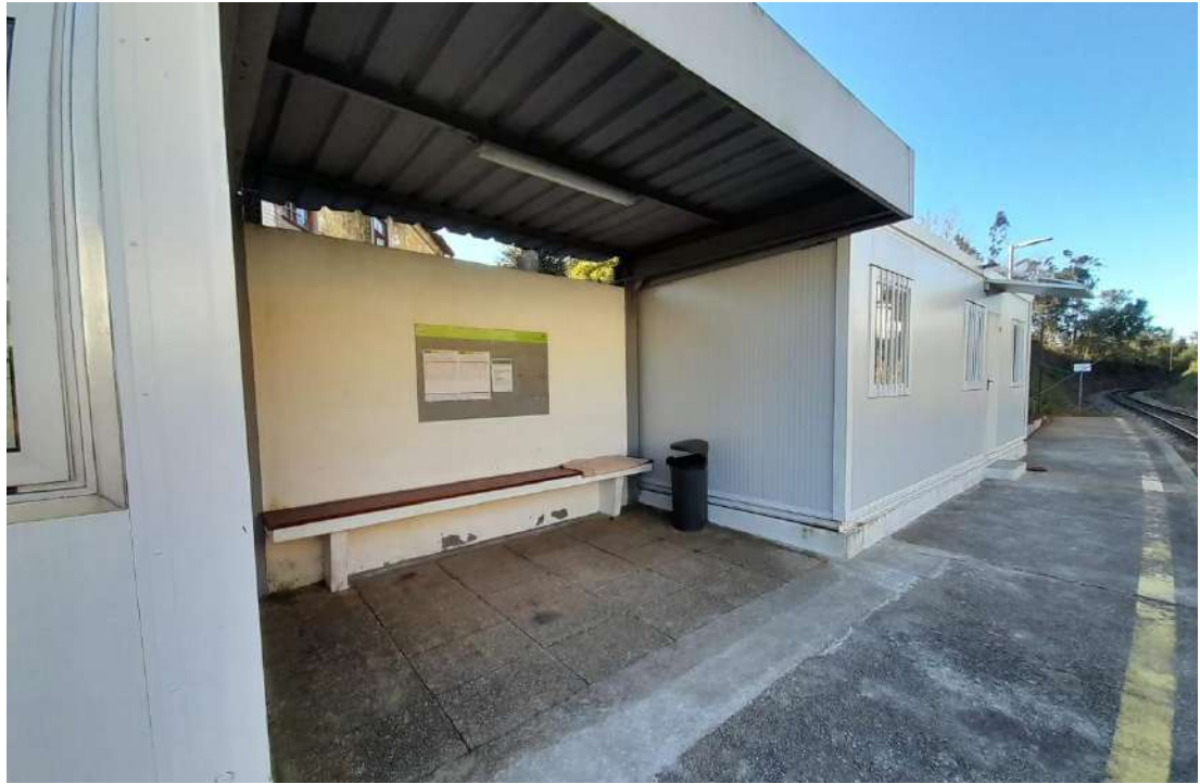
Figura 101. Equipamentos de apoio ao utilizador no apeadeiro Sanfins
