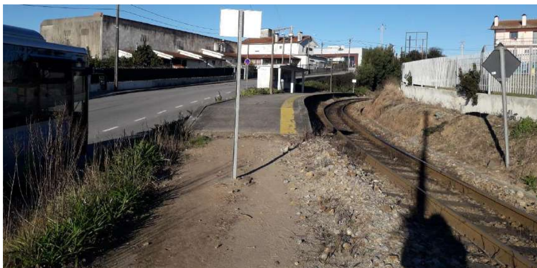
Figura 115. Falta de pavimentação adequada no acesso ao cais
