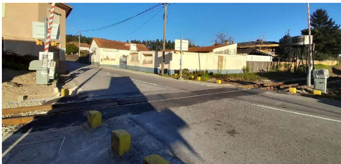
Figura 112. Passagem de nível junto à Rua São João
