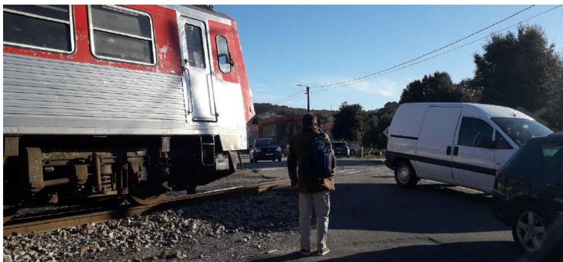
Figura 116. Passagem de nível junto a Rua Moinho das Campainhas
