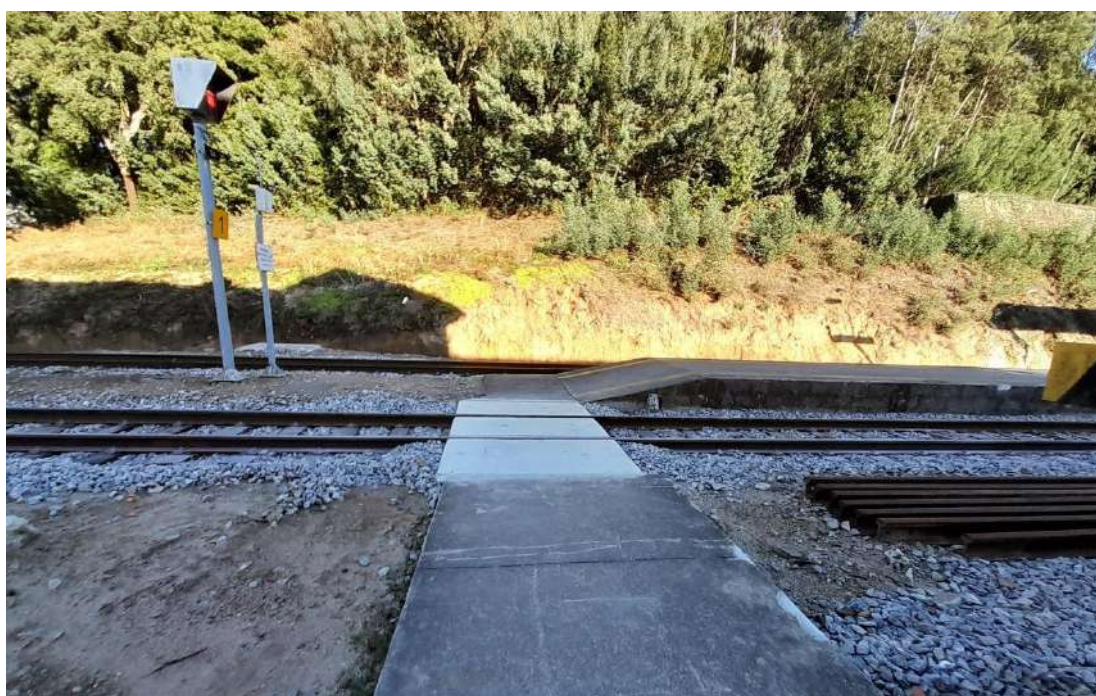
Figura 98. Travessia da plena via para acesso ao cais
