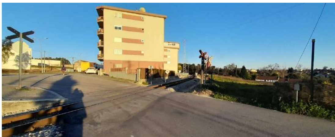
Figura 104. Passagem de nível junto à Rua Lapa de Baixo
