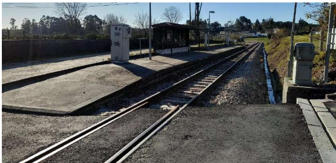
Figura 119. Condições de acesso ao apeadeiro Escapães
