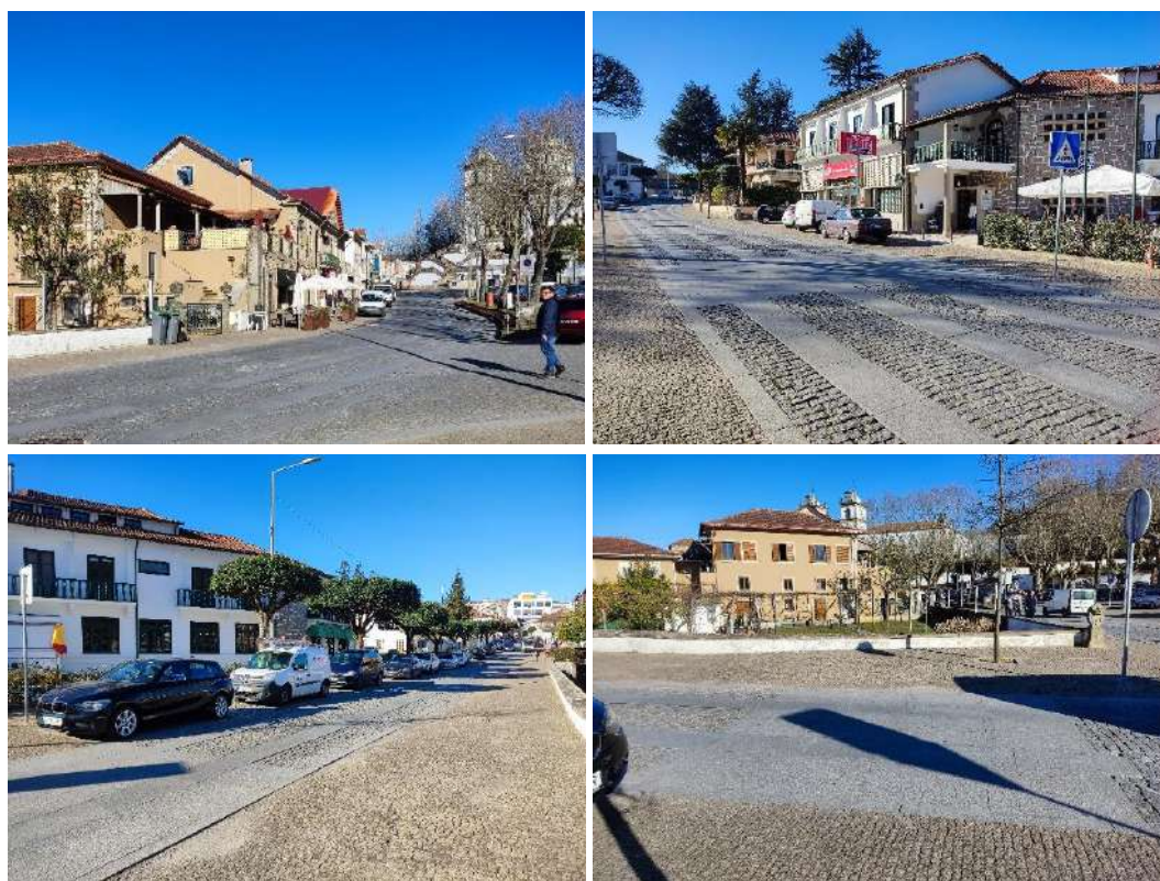
Figura 56. Plataforma única da Rua António de Castro Corte Real, Rua dos Descobrimentos e Praça de Camões
