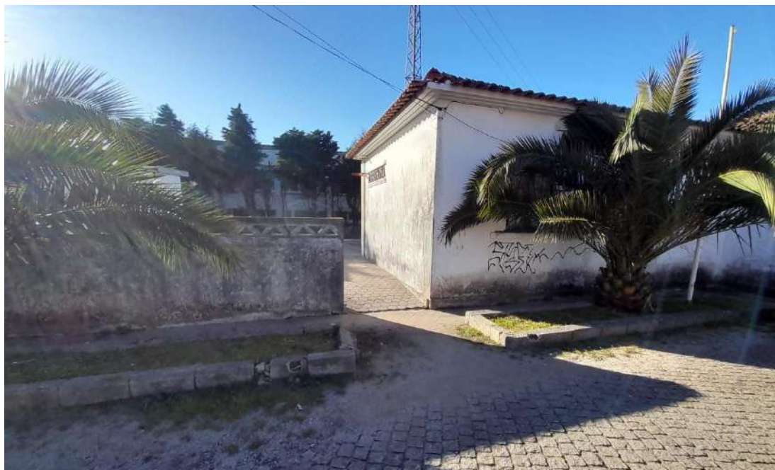
Figura 122. Condições de acesso ao cais do apeadeiro Arrifana
