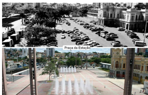
Plaza de la Estação
