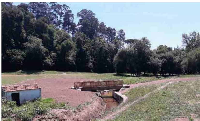
Aspetto final dos trabalhos junto à Ribeira de Cáster
