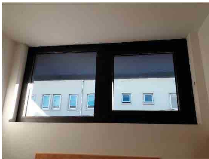
Novos vãos envidraçados instalados no Cineteatro António Lamoso
