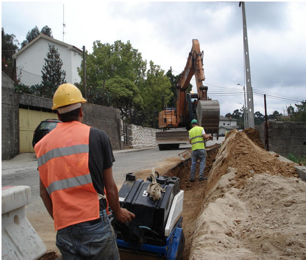
Construção de Interceptores
