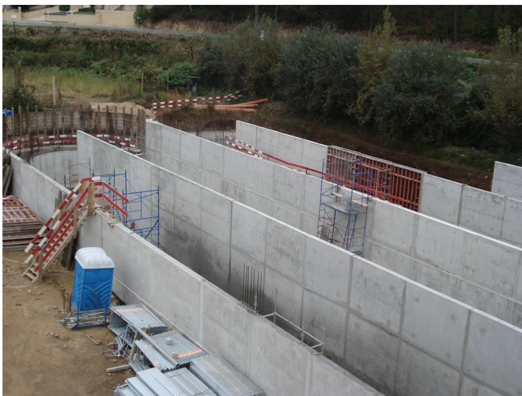
Obras de construção da ETAR de Argoncilhe
