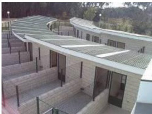
Figura - Aspecto geral do CIAMTSM
