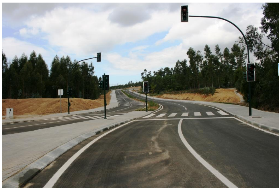
Via de Acesso ao Parque Empresarial da Cortiça – 1.ª Fase
