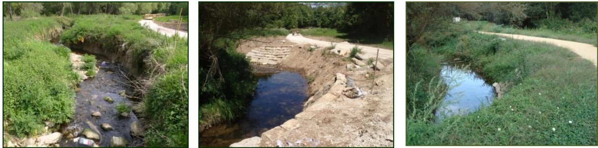
Figura 2: Estabilização de margens através da utilização de enrocamento vivo.
