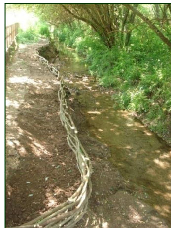
Figura 3: Estabilização de margens através da utilização de faxinas vivas de salgueiros
