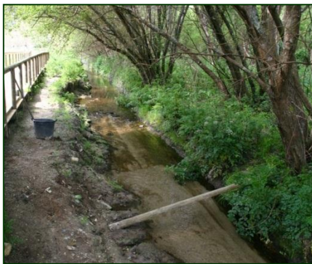
Figura 3: Estabilização de margens através da utilização de faxinas vivas de salgueiros
