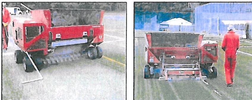
Em simultâneo com a aplicação das cargas de enchimento, a oscilação da unidade de escovas permite nivelar, num só processo, o material de enchimento.
