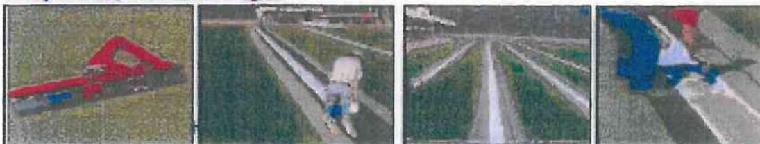
As linhas de marcação serão da mesma fibra e concepção do tapete, sendo encastradas e coladas por processo em tudo idêntico ao descrito anteriormente para a união entre os rolos. Não se incluem aqui as linhas incorporadas em fábrica. O corte do tapete nas zonas de encastração das linhas será feito com recurso a ferramentas apropriadas (facas de corte duplo).
